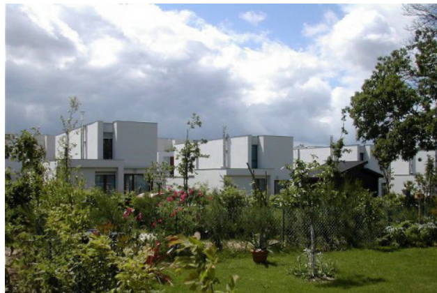
Habiter le parc Saint-Jacques-de-la-Lande - CITA architectes Lien étroit entre les constructions et l'espace public situé à l'arrière des jardins.
